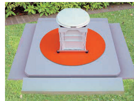
5 FRP 便器を床版の中央に設置します。
