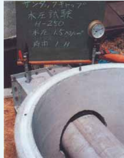
水圧試験 ヒューム管用呼び径250変位なし 水圧1.5kgf/cm 2 -1時間異常なし
