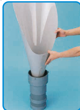
④接続用ソケットを装着して管に差し込み、蝶ボルトで締める。
