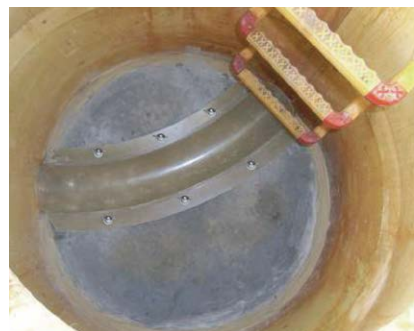
3 インバートカバーを設置。蝶ナットで調整固定
