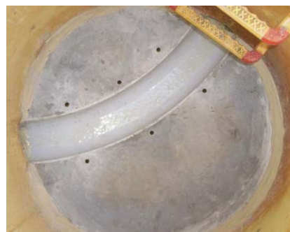
2 下穴を開けアンカーを打ち込む
