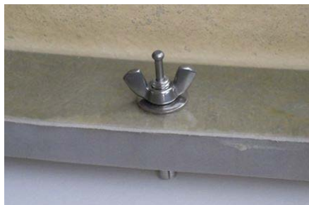
■圧着調整蝶ナット(手回しが可能)
