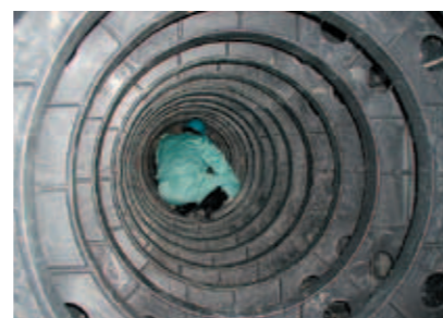
槽内点検状況
