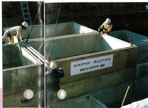
本体据付・接着
