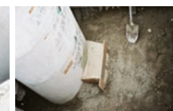
コンクリート打設後埋め戻し完了
