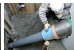
取付状況(ベンド管側)
