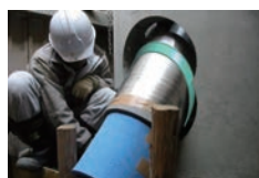
取付状況(削孔口)
