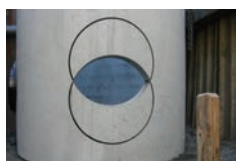
マンホールへの削孔は2連で孔ける
